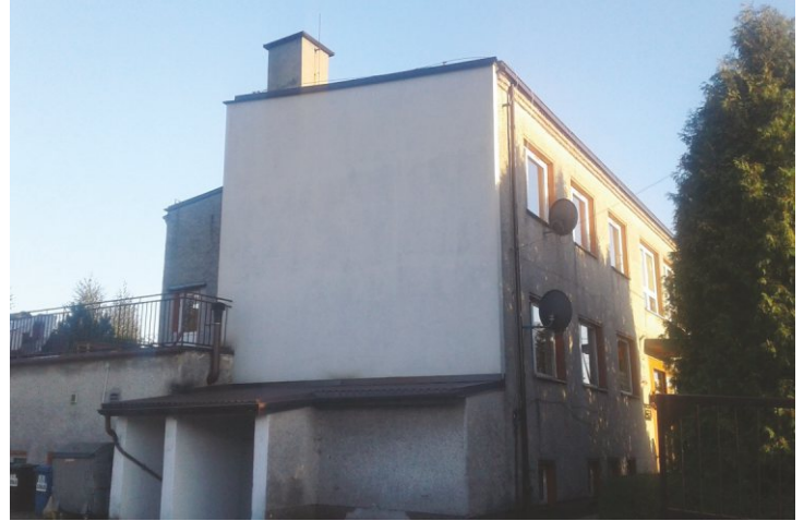
Szkoła Podstawowa w Jackowie: remont dachu, docieplenie ścian – 41 667 zł
