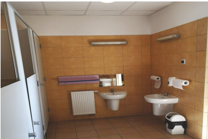
Przedszkole w Kruszynie: adaptacja pomieszczenia na toaletę – 13 983 zł
