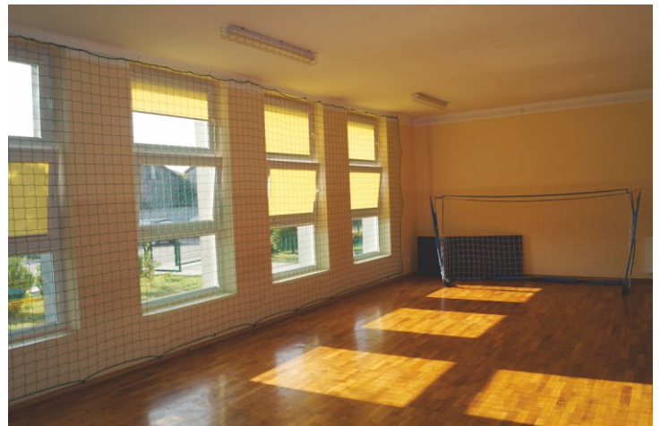
Szkoła Podstawowa w Widzowie: remont sali gimnastycznej, cyklinowanie parkietów, wymiana instalacji elektrycznej, wymiana drzwi, malowanie sal – 71 442 zł
